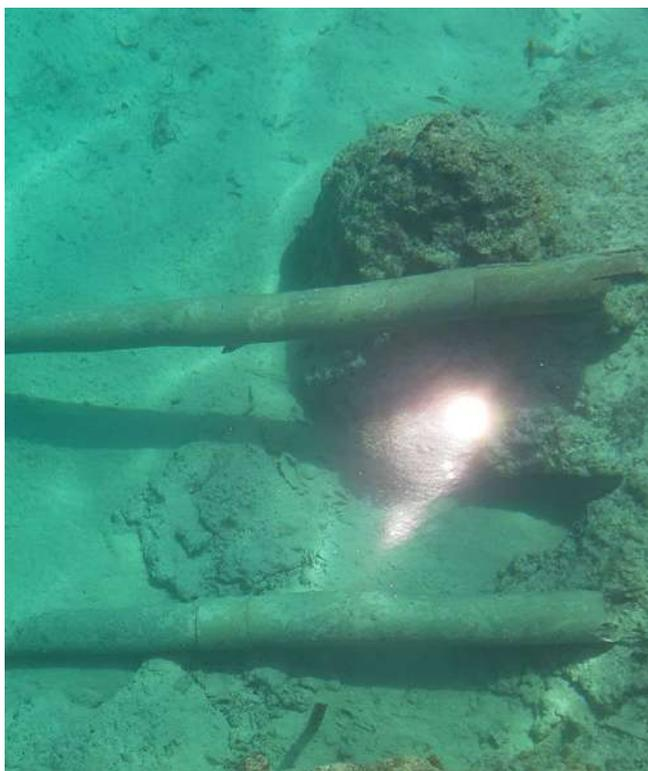
Figure 16 : Poteau en PVC et corps-morts constitué d'un fût métallique rempli de ciment (Ahe) (photo : G. Bouvet).
